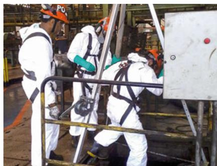
Limpeza e desinfecção de diversos tipos de tanques e reservatórios de Óleo Hidráulico, Óleo Diesel ou outros tipos de fluídos. O processo é realizado através da remoção de incrustações e sujeiras impregnadas nas paredes dos tanques, utilizando processos diferenciados, garantindo o padrão de limpeza desejada.
