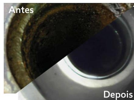
Limpeza de tubulações novas ou usadas nos mais variados diâmetros. Processo de limpeza elaborada através de soluções ácidas e/ou alcalinas, com produtos de última geração, objetivando rapidez, simplicidade, menor impacto ao meio ambiente e geração mínima de resíduos. Nossa engenharia garante a eficiência! Entregamos memória de cálculos, efetuamos ensaios hidrostáticos e boroscópicos “in loco”.
